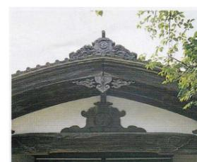
玄関屋根の起り破風と蕪懸魚 破風とは、軒の三角形部分をさし、破風板が上方に凸形に反ったものを起り破風という。棟木の端を隠す飾りが蕪懸魚で、掛川城御殿のものは蕪懸魚と呼ばれる。
