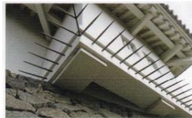
石落とし 天守台の張り出し部に設けられ、石を落としたり、槍を突き出したりして、石垣を登ってくる敵を攻撃する施設。
